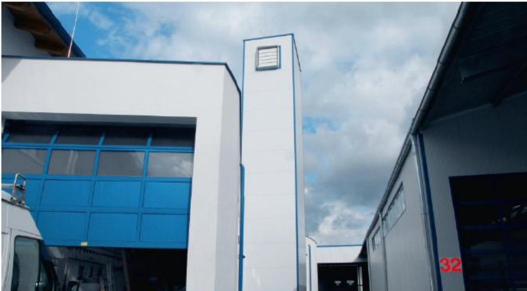
Из-за окружающей транспортной инфраструктуры, лифтовой автоматизированный склад установлен на внешнем фасаде склада и отделан панелями.
